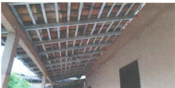
COBERTURA LATERAL EXTERNA
