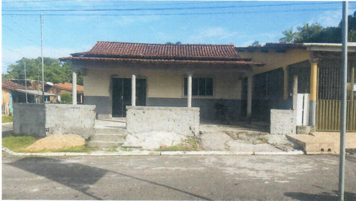
FOTO: 01-VISTA DA FRENTE
