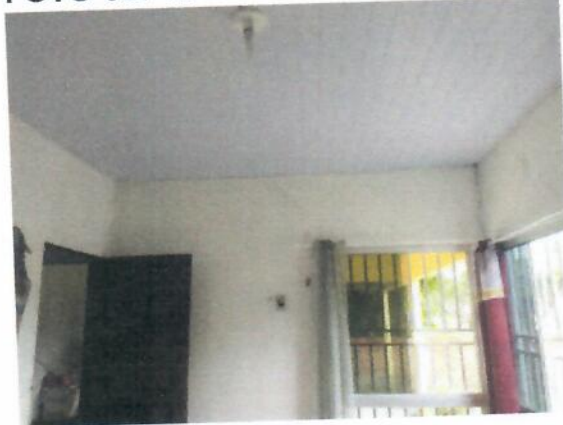
FOTO-05: TIPO FORRO EXISTENTE
