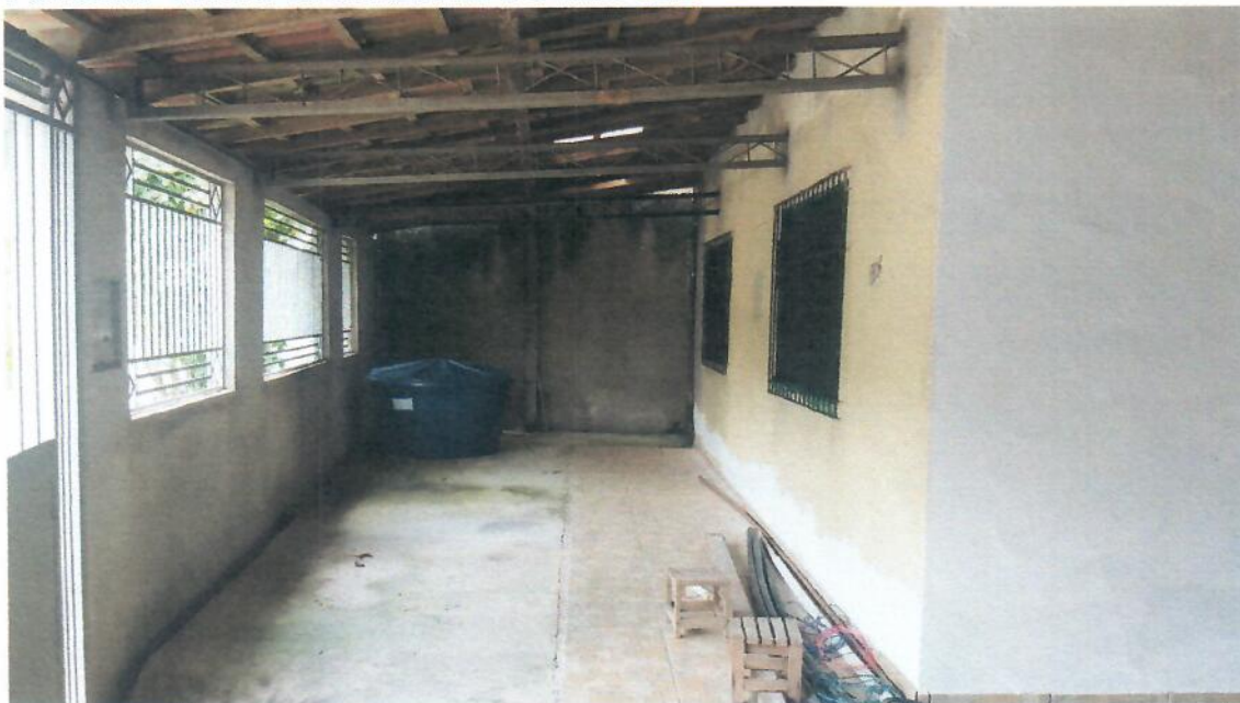
FOTO:02- PÁTIO DA FRENTE DO IMÓVEL
