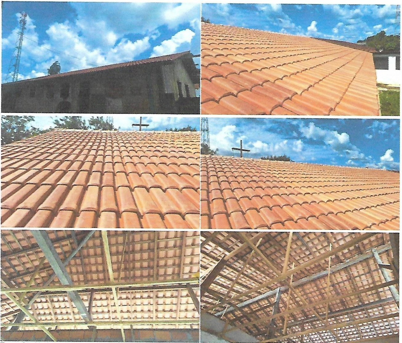
Fotos: 01, 02, 03, 04, 05 e 06 – Cobertura e Estrutura do forro
