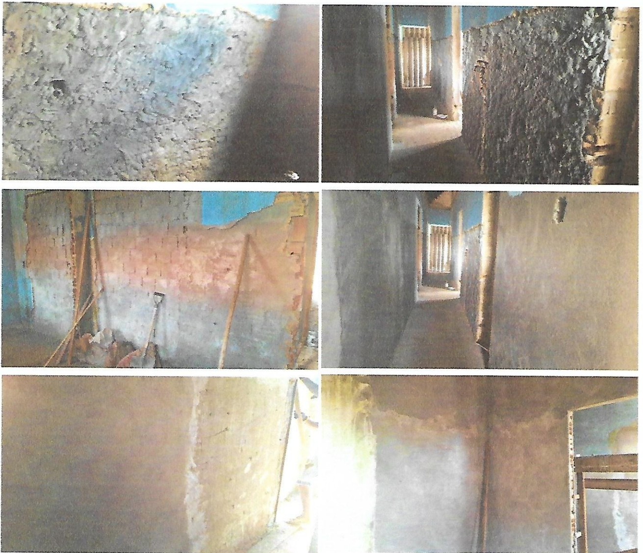
Fotos: 07, 08, 09, 10, 11 e 12 – Fundação corrida, Chapisco, Emboço e Reboco
