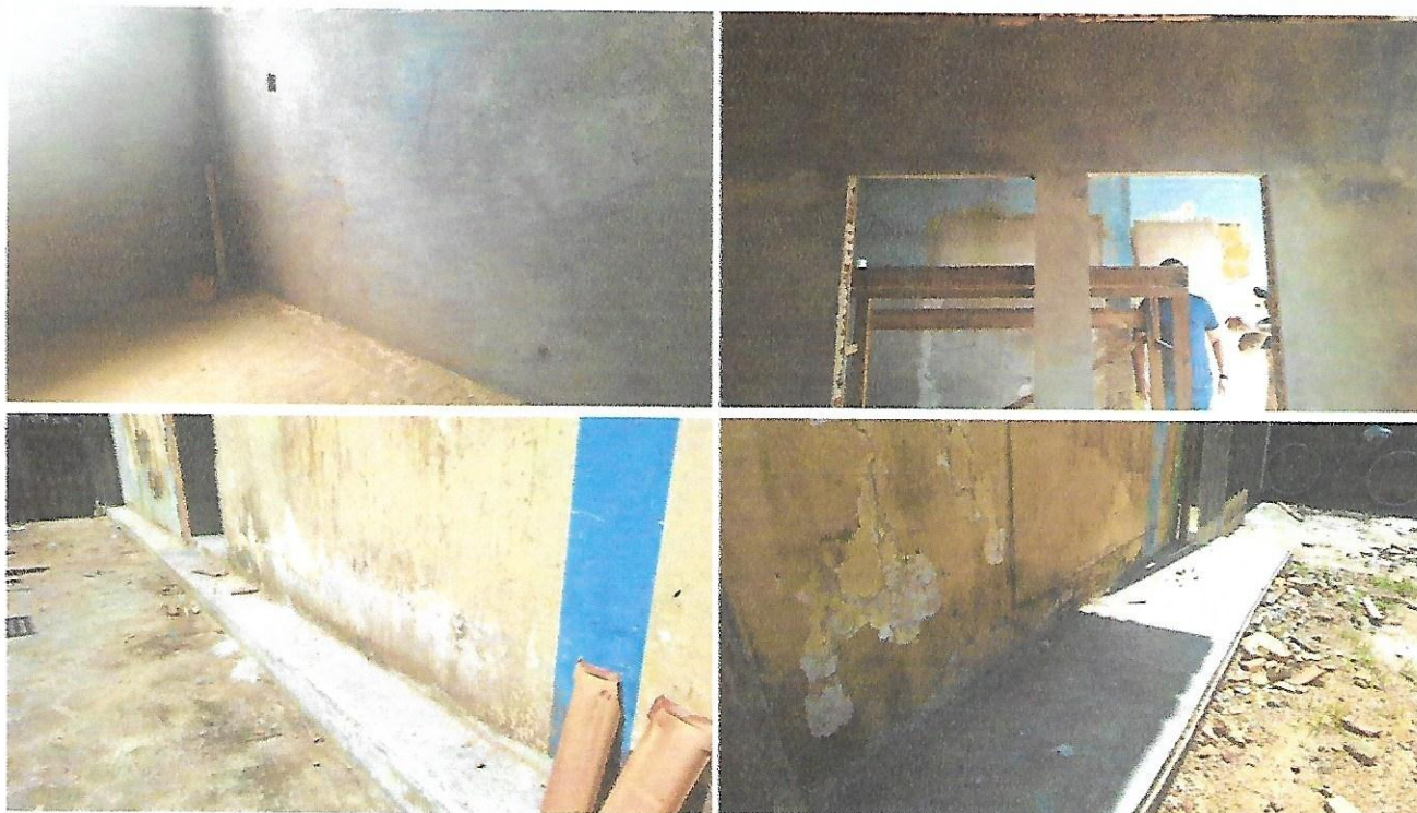
Fotos: 13, 14, 15 e 16 – Fundação corrida, Reboco e Calçada
