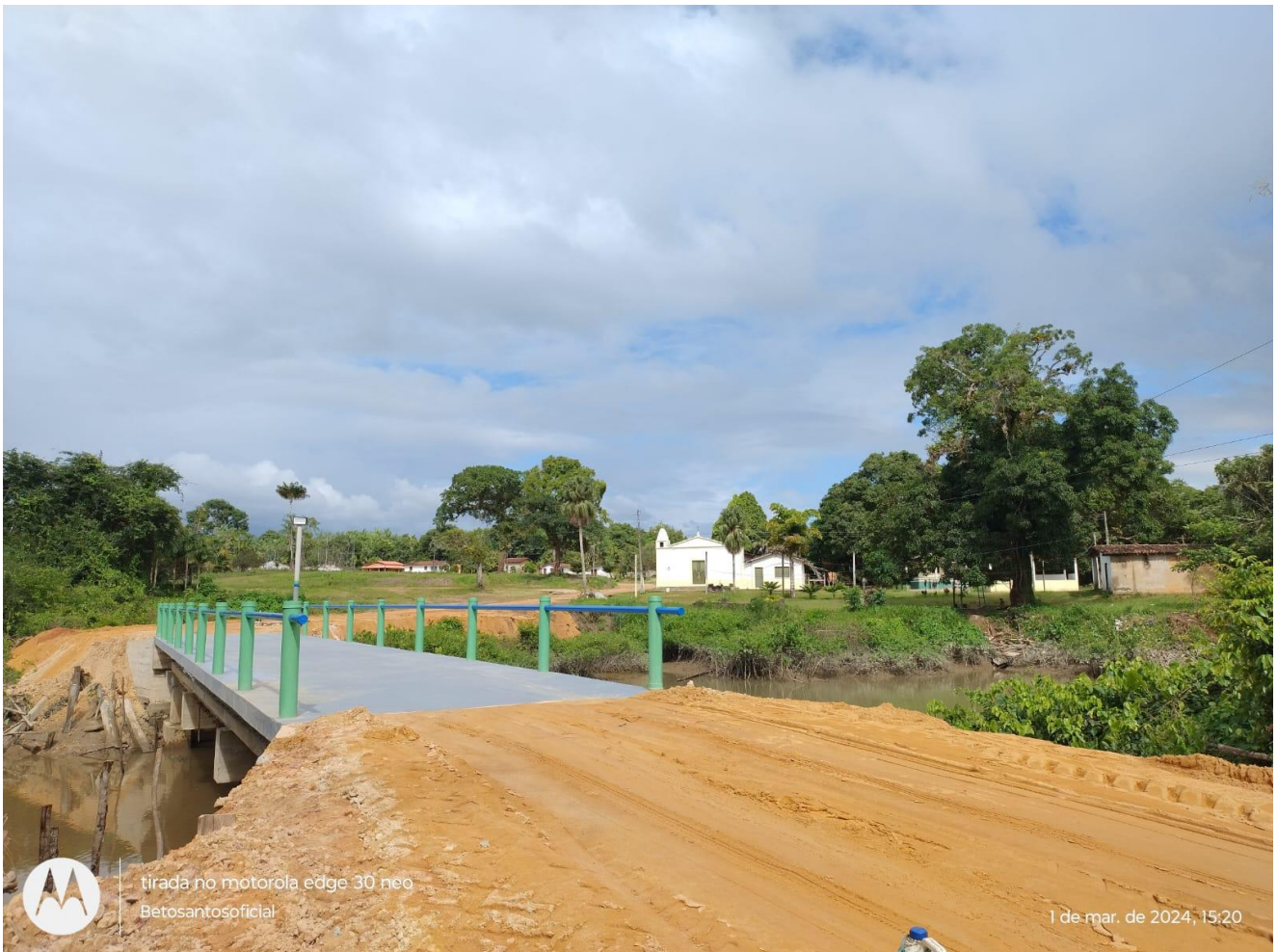
FOTOS: 06 – PONTE EM CONCRETO - FINALIZADA
