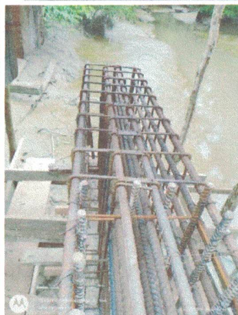
FOTOS: 01, 02, 03, 04, 05, 06 E 07 – FORMAS E FERRAGENS DOS PILARES E VIGAS
