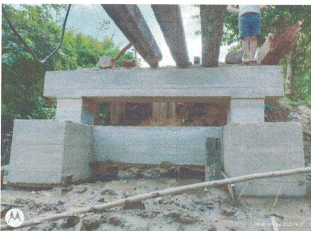
FOTOS: 14, 15, 16 e 17 – CONCRETO ARMADO DE PILAR E VIGA
