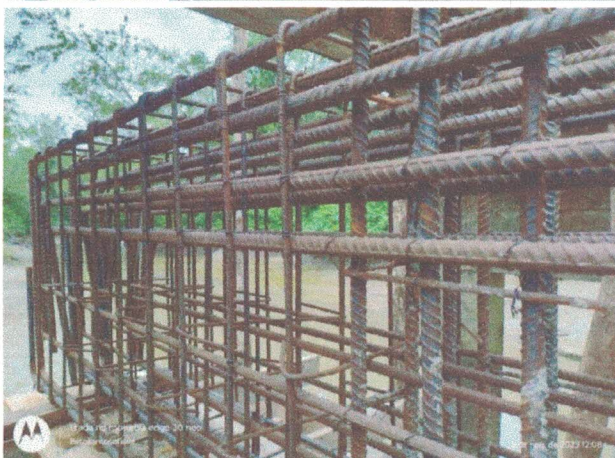
FOTOS: 01, 02, 03, 04, 05, 06 E 07 – FORMAS E FERRAGENS DOS PILARES E VIGAS
