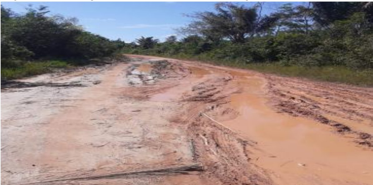
Imagem 08- mostra trecho próximo a entrada de acesso a localidade Tauapara.
