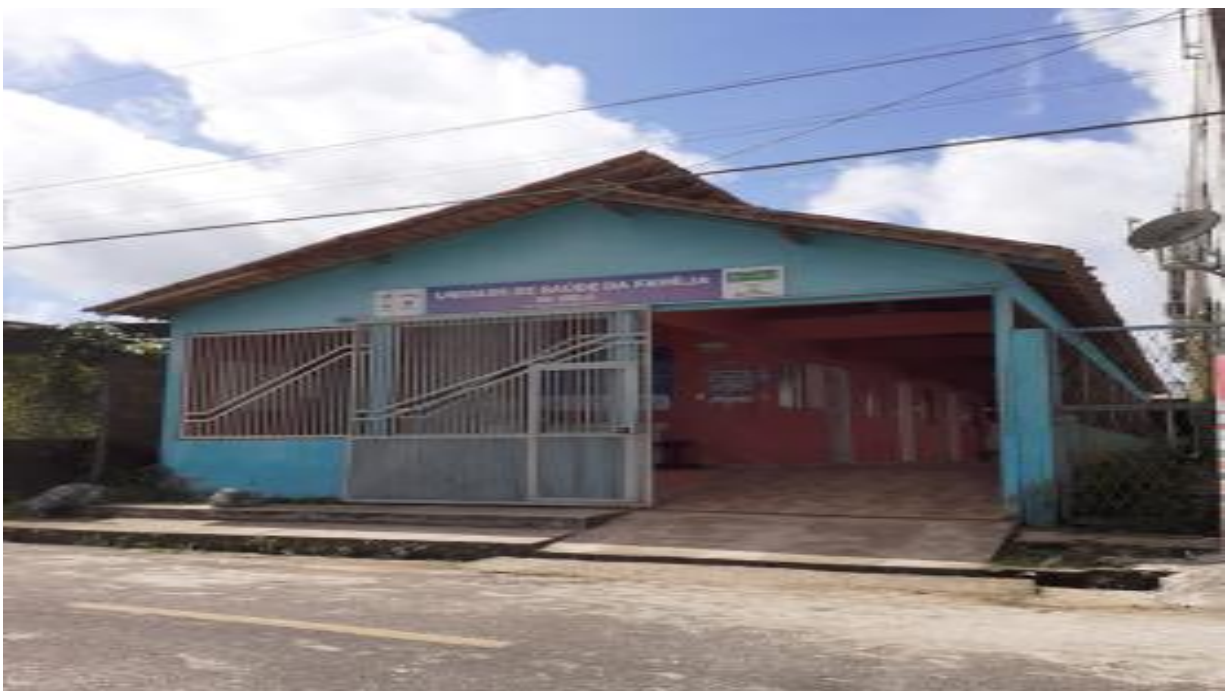
Imagem 15- mostra fachada externa do ESF Orla.
