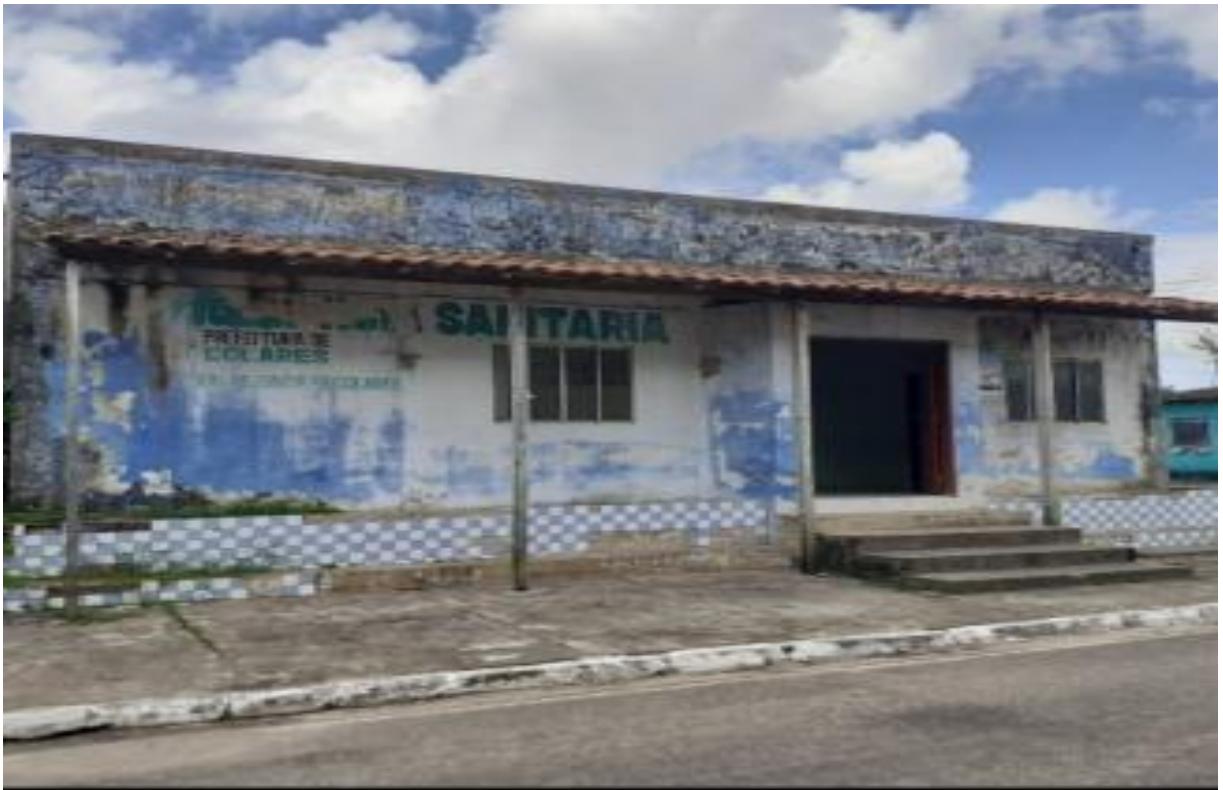
Imagem 16- Mostra o prédio onde funciona a VISA.
