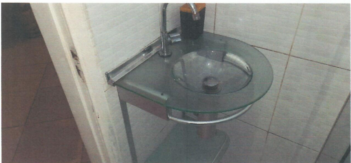
Foto 22 – Lavatório do banheiro social
