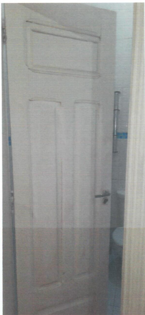
Foto 29 – Porta interna em madeira de banheiro
