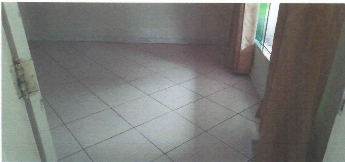
Foto 13 – Piso da sala 03
