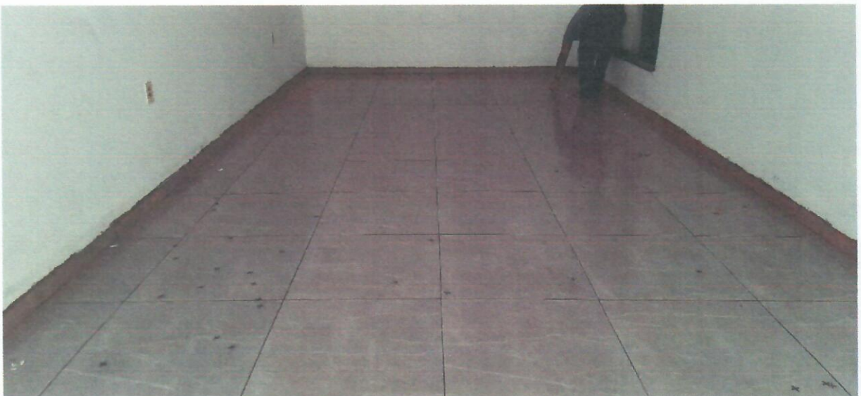
Foto 06 – Piso da garagem
