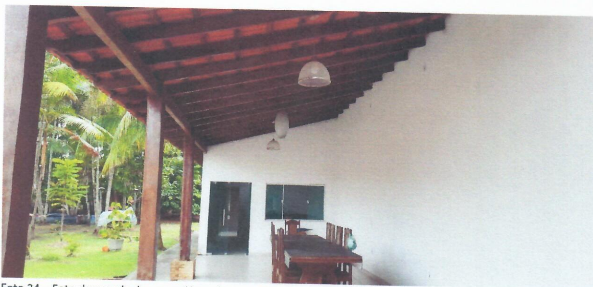
Foto 34 – Foto da parede do anexo (área de apoio 02)
