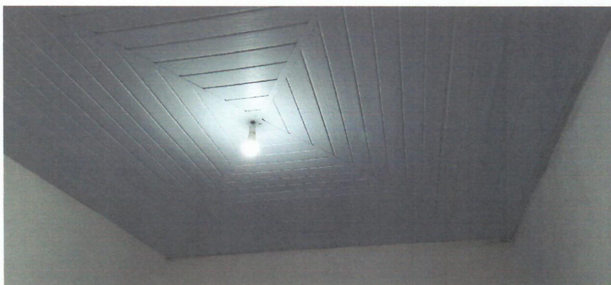
Foto 18 – Forro da sala 06
