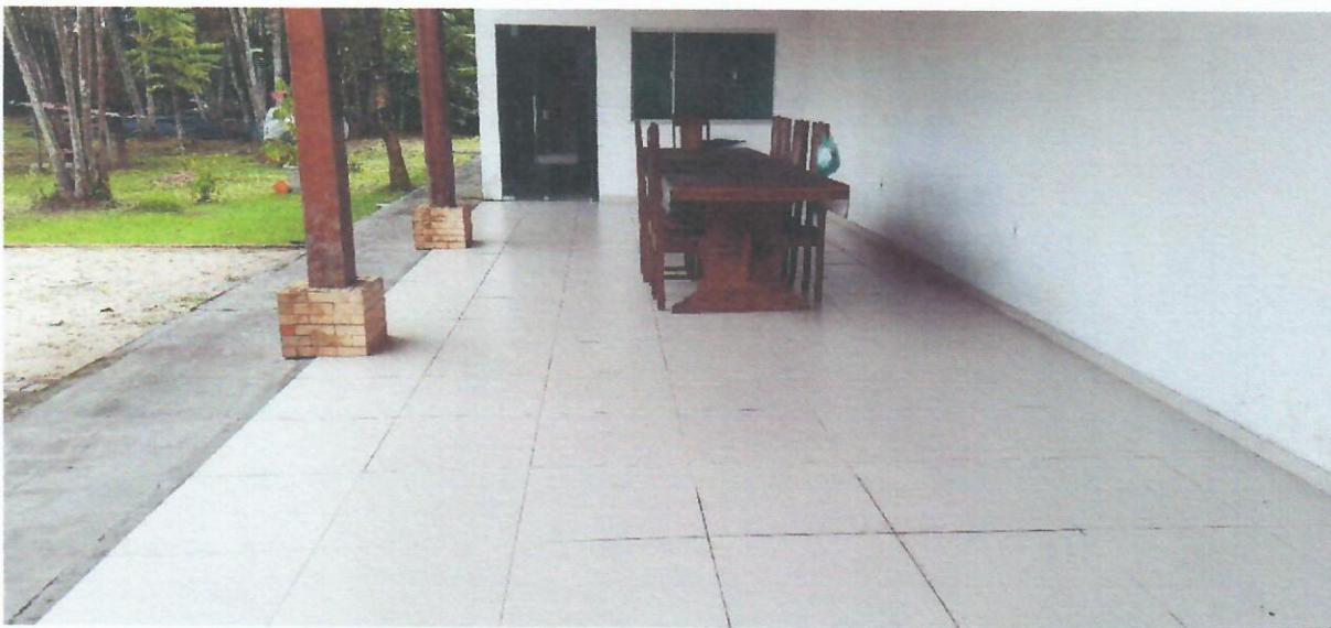
Foto 35 – Foto do piso do anexo (área de apoio 02)
