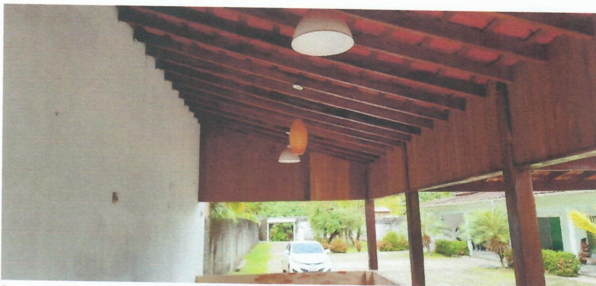
Foto 37 – Foto da parede do anexo (área de apoio 01)
