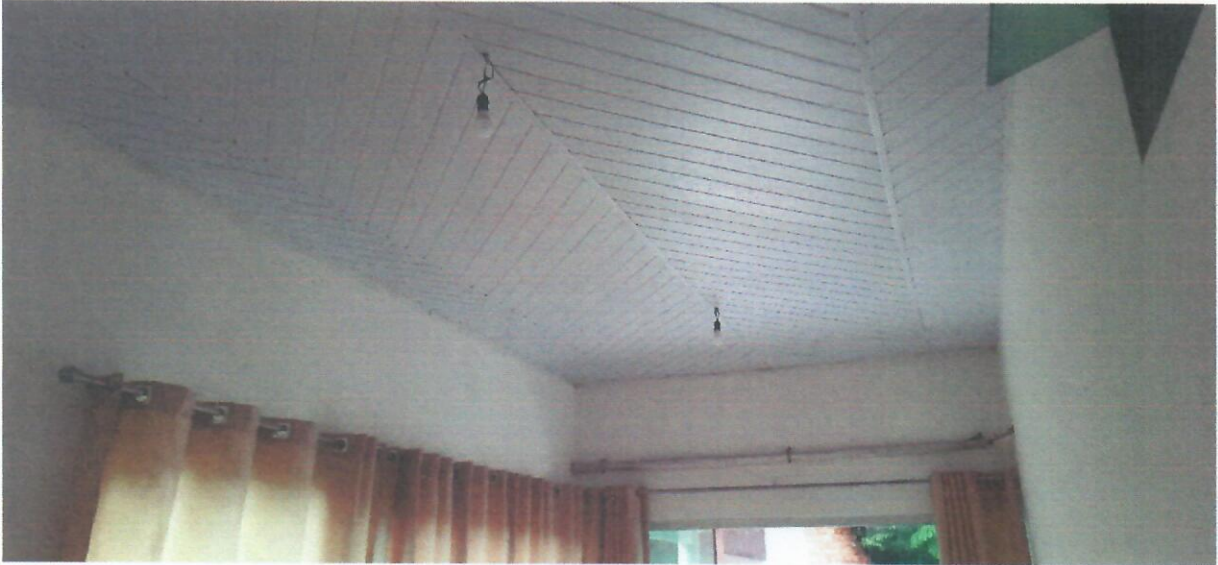
Foto 09 – Forro da sala 04
