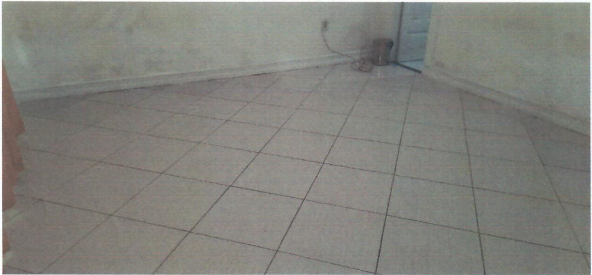
Foto 15 – Piso da sala 05
