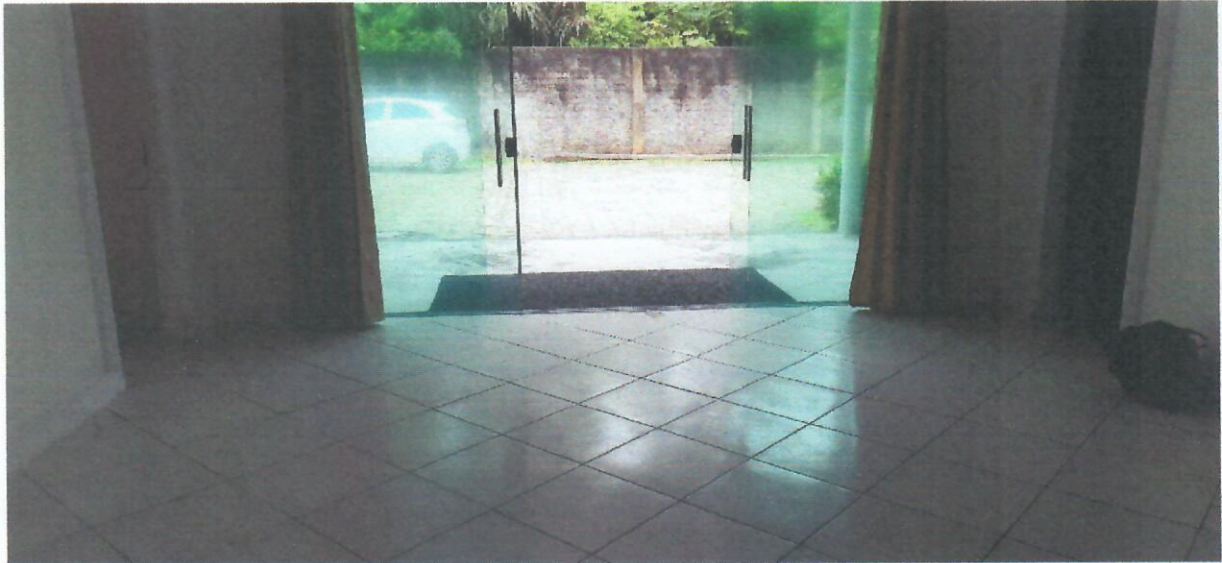
Foto 11 – Piso da sala 01
