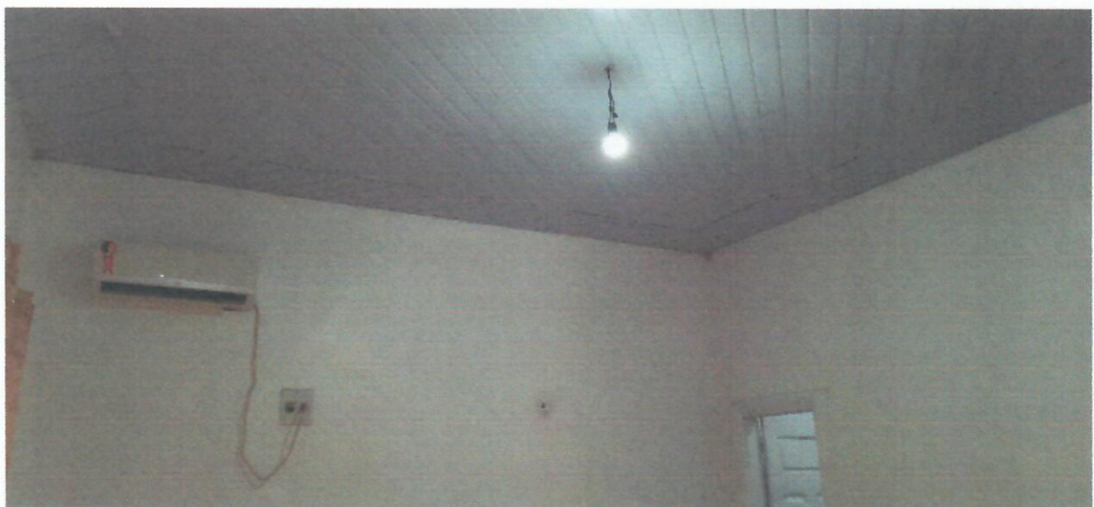
Foto 16 – Parede da sala 05
