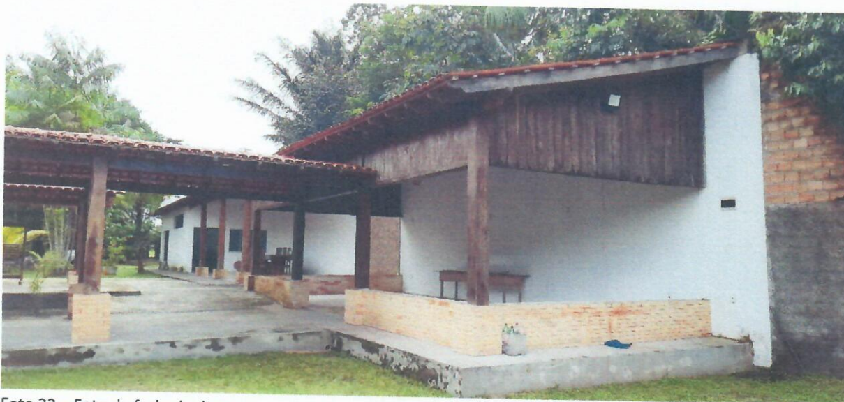
Foto 33 – Foto da fachada do anexo
