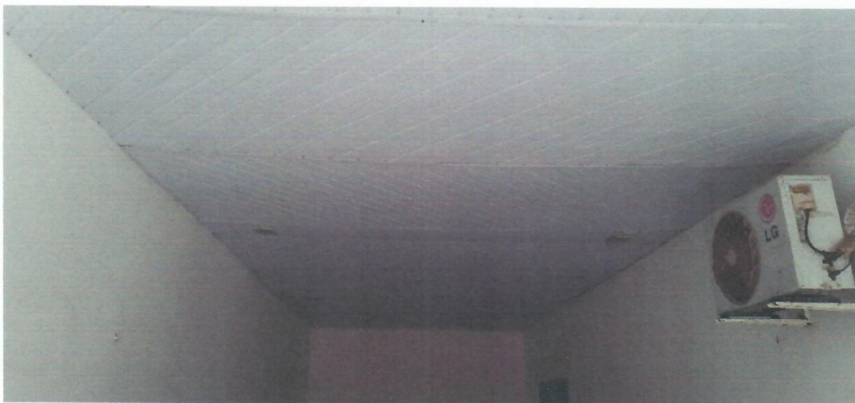
Foto 07 – Parede e forro da garagem
