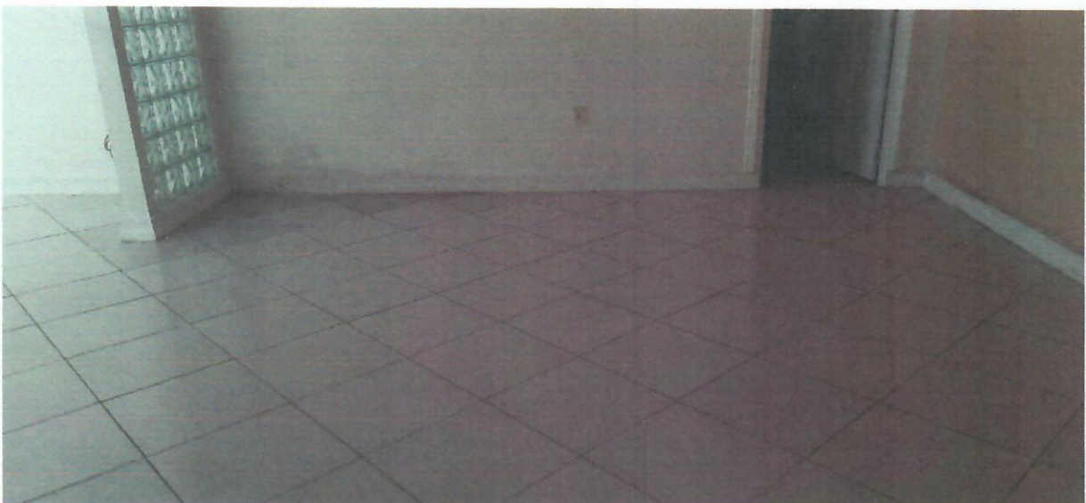
Foto 10 – Piso da sala 02
