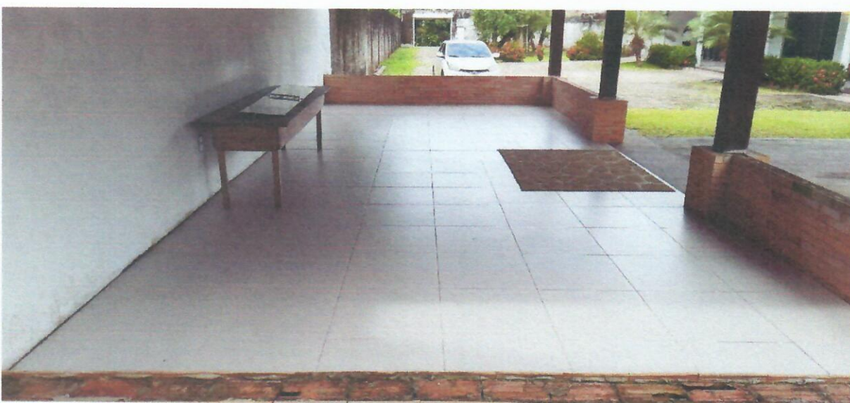
Foto 36 – Foto do piso do anexo (área de apoio 01)
