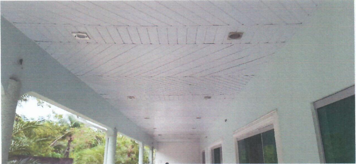
Foto 05- Forro da circulação
