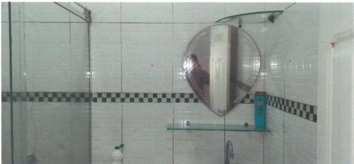
Foto 28 – Box do banheiro da sala 08
