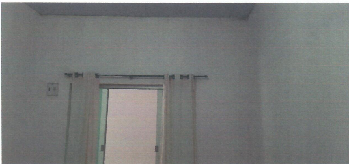
Foto 17 – Parede da sala 06
