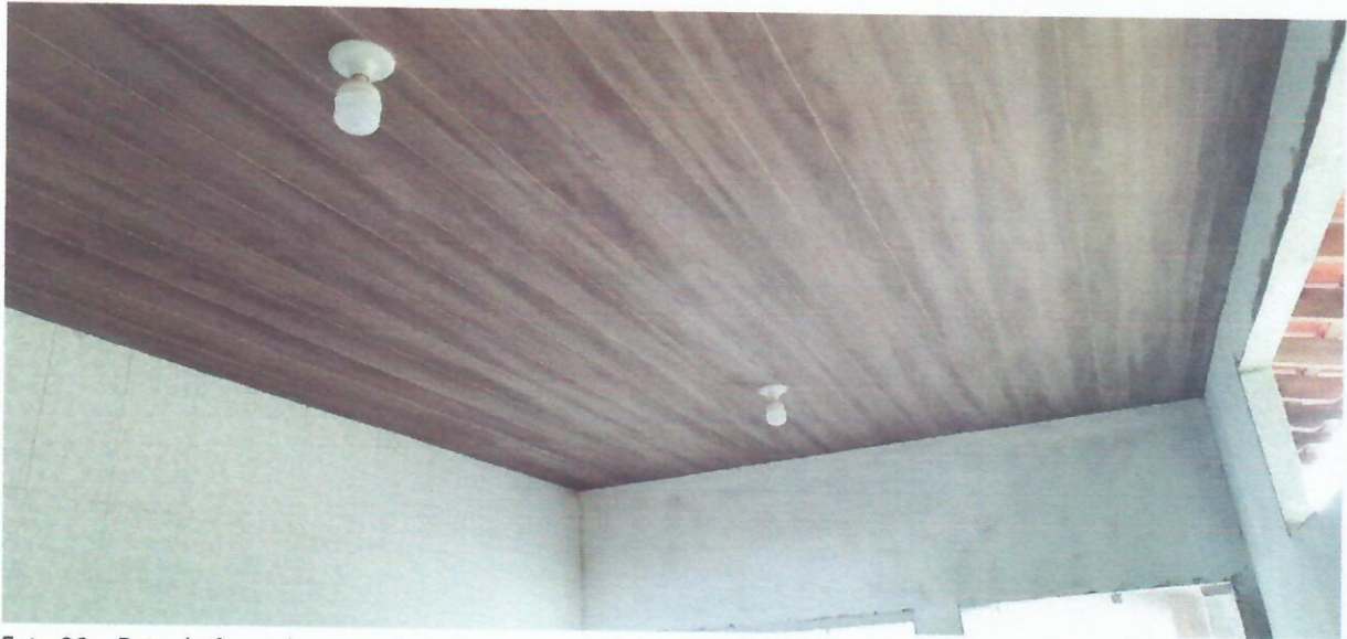
Foto 39 – Foto do forro do anexo (cozinha)
