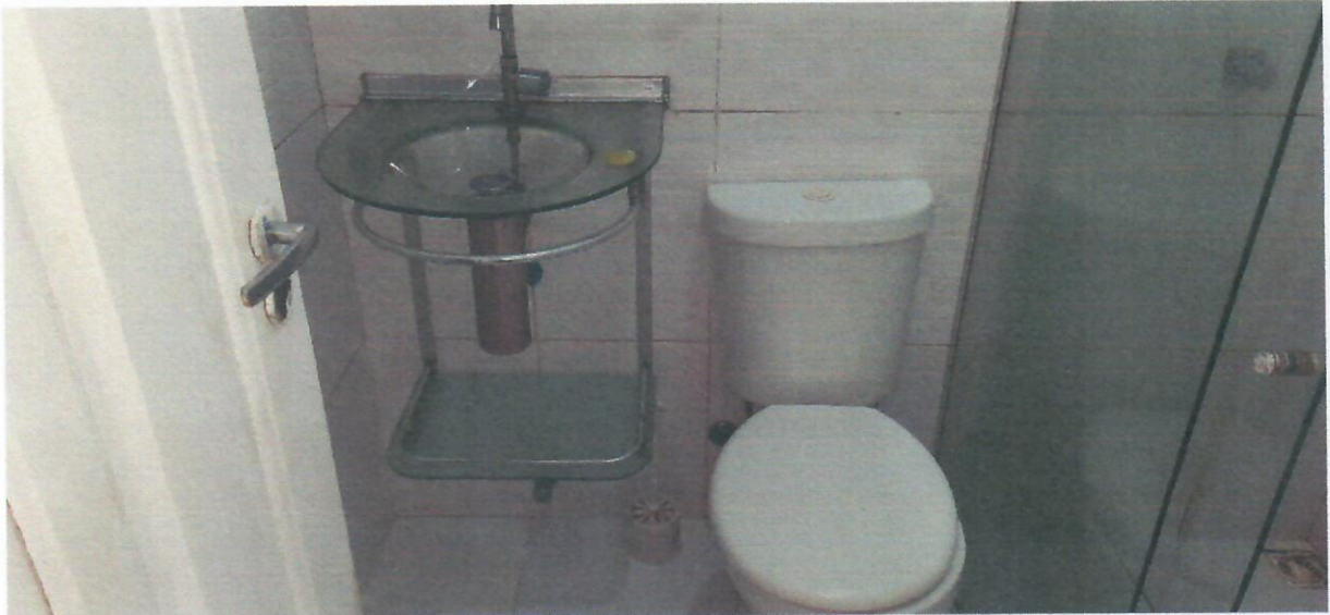
Foto 25 – Vaso e lavatório do banheiro da sala 05
