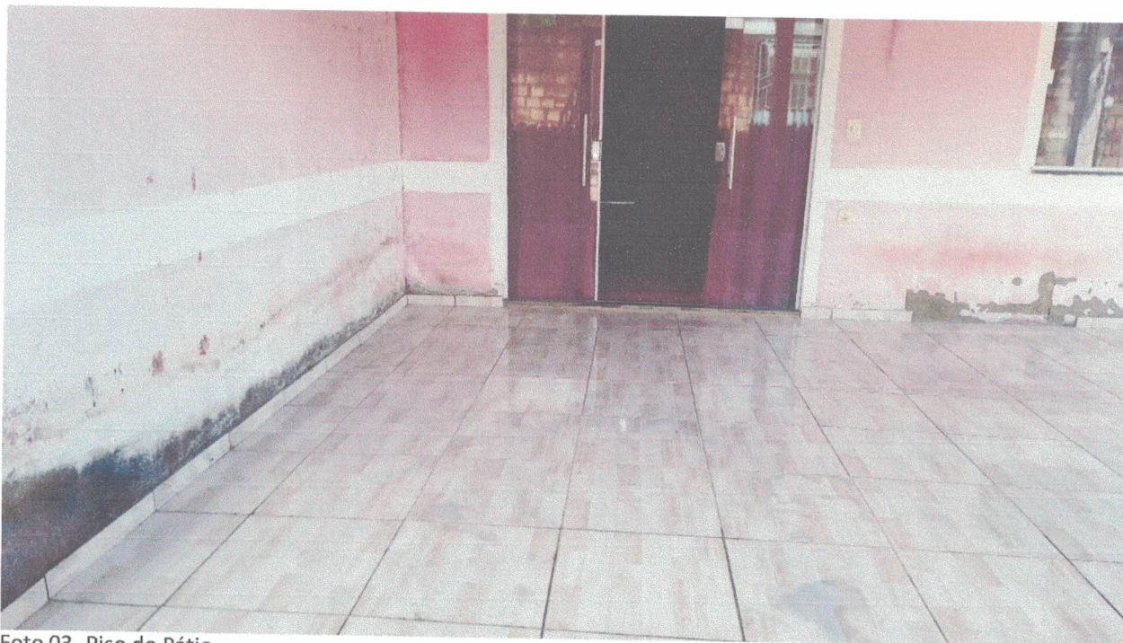
Foto 03- Piso do Pátio
